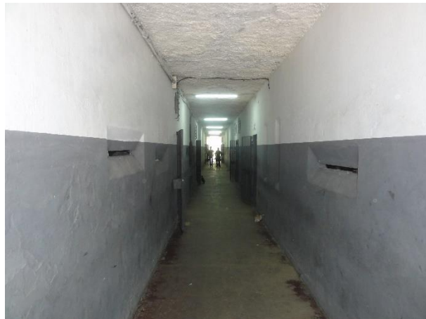
Figura 6 corredor centra do Pavilhão A
