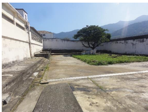
Figura 6 visão esquerda do portão de acesso
