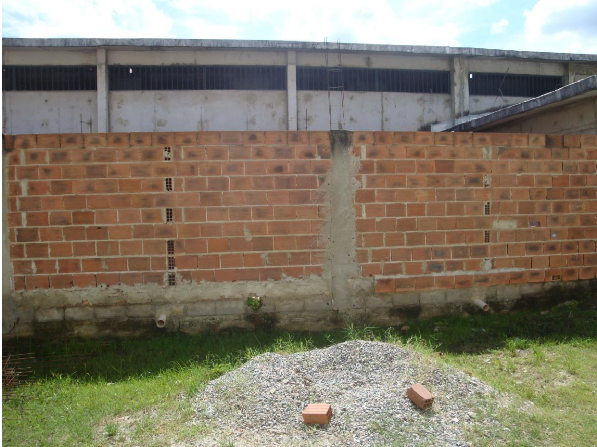
Foto da obra do parlatório
