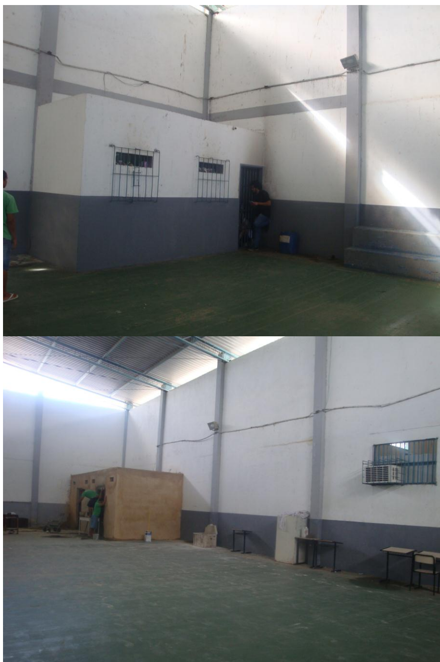
Imagens 31 e 32 – Cella de isolamento e cela sendo construída para isolamento
