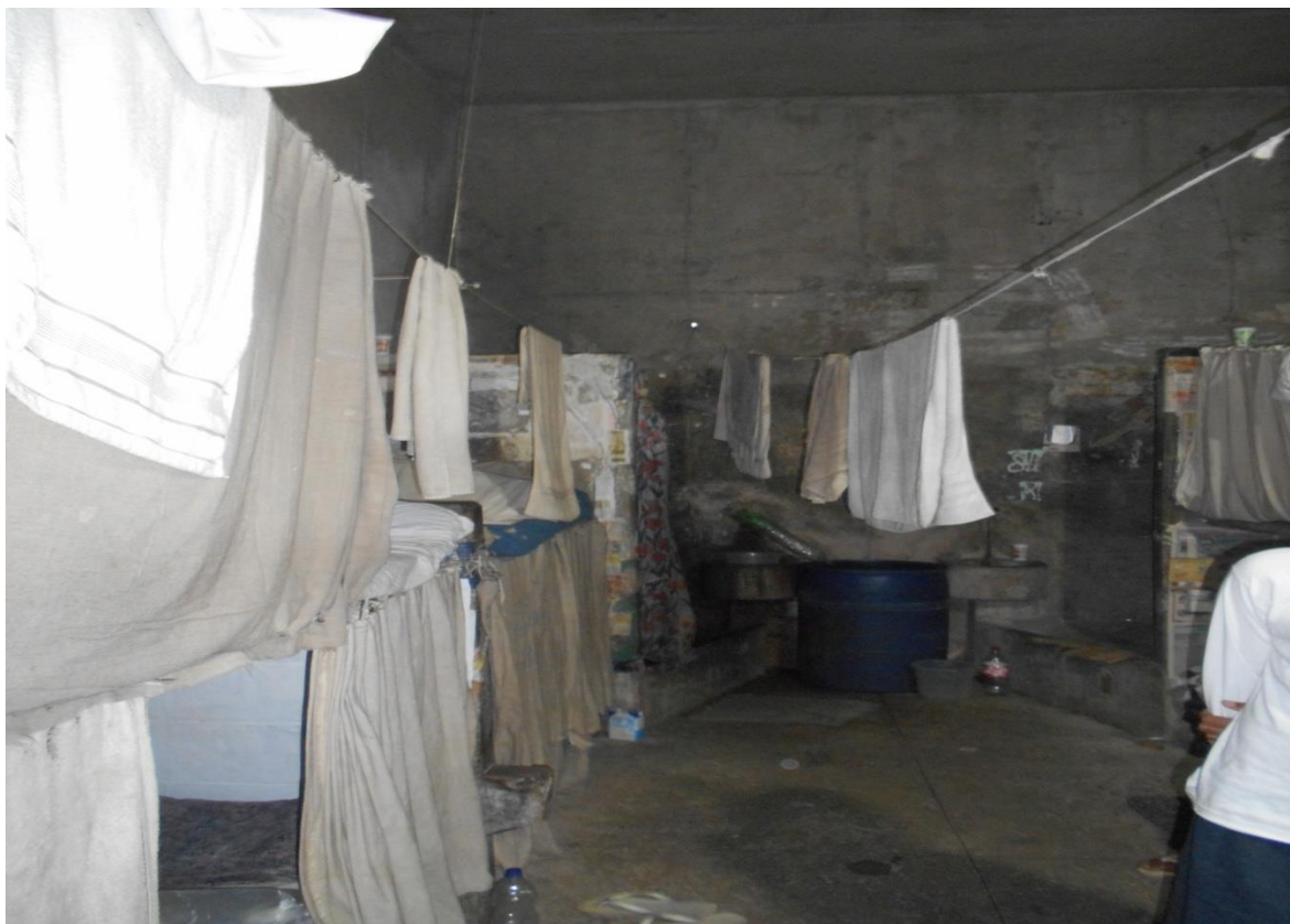
Exemplo de cela coletiva no Presídio João Carlos da Silva em que se pode notar a sujeira, a umidade e as infiltrações.
