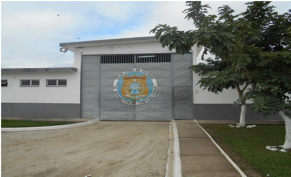
Portão que dá acesso ao setor administrativo e aos setores onde ficam galerias e celas.
