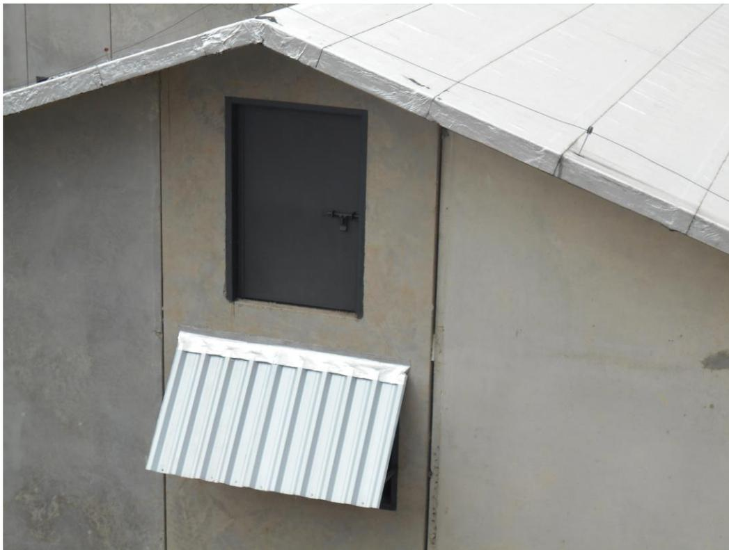
Foto 14. Visão externa da chapa que impede a livre circulação de ar e entrada de luz natural adequada nas celas.
