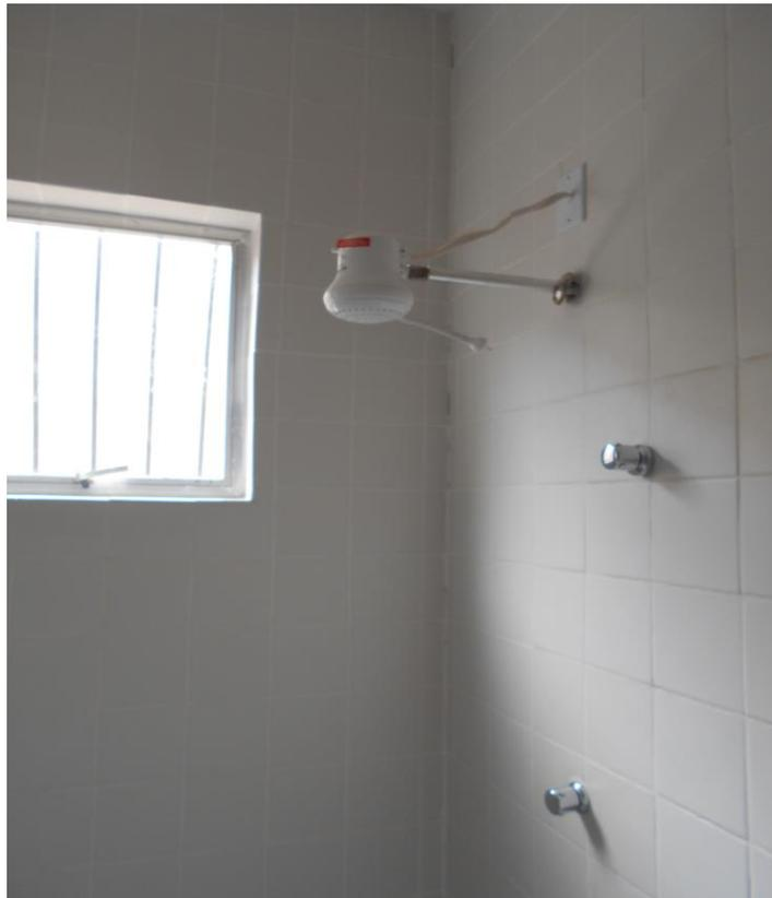
Foto 22. Chuveiros elétricos instalados em uma das áreas técnicas.
