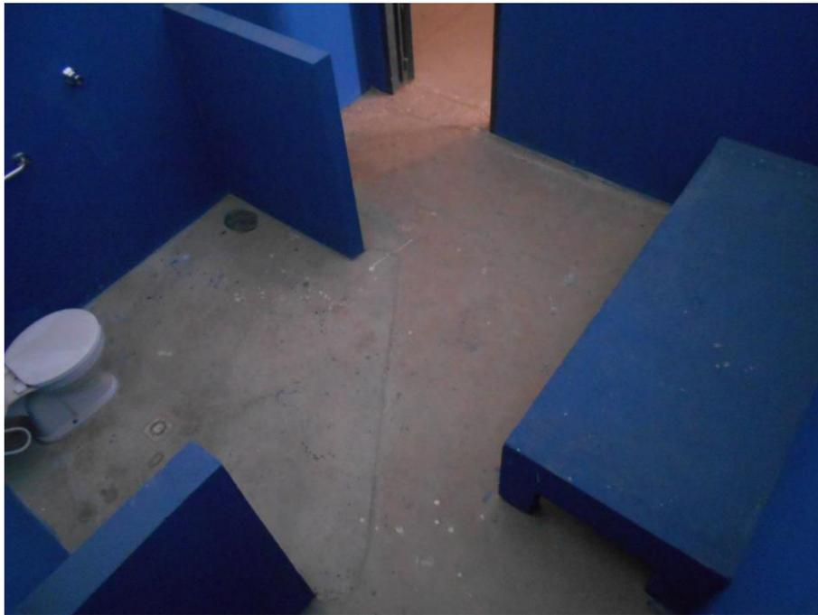
Foto 19. Cella teoricamente adaptada para cadeirantes, na foto é possível notar o vaso sanitário no mesmo nível do resto do chão.
