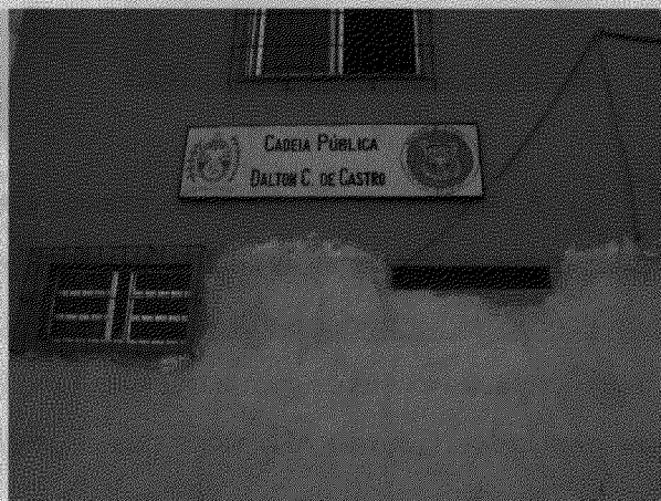
Parede externa da Unidade.
