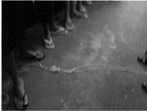
Fiação inadequada da cela.
