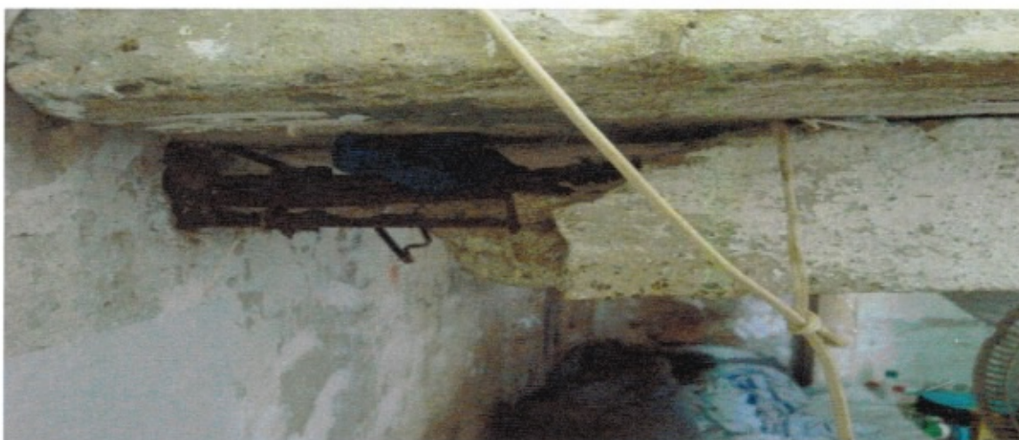
Imagem 4 - o que deveria ser o suporte de uma comarca, absolutamente comprometido e oferecendo riscos aos que ali dormem.
