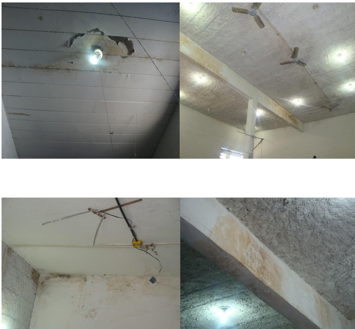
Infiltrações nas celas coletivas.
