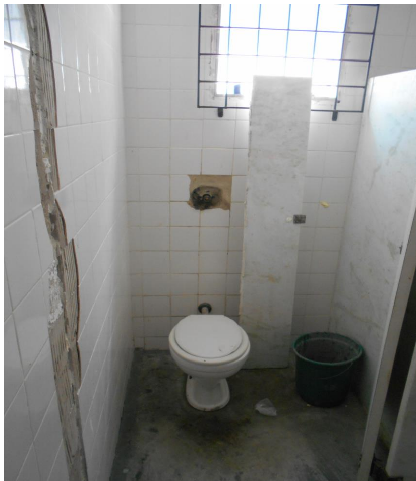
Banheiro do alojamento na Unidade.
