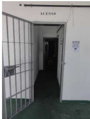
acesso às galerias
