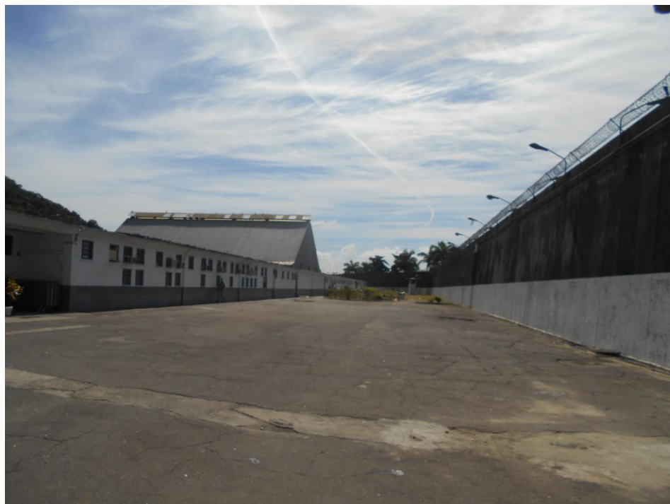
Vista por dentro dos muros da Penitenciária Alfredo Tranjan.
