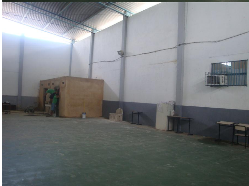
Imagens 31 e 32 – Cela de isolamento e cela sendo construída para isolamento
