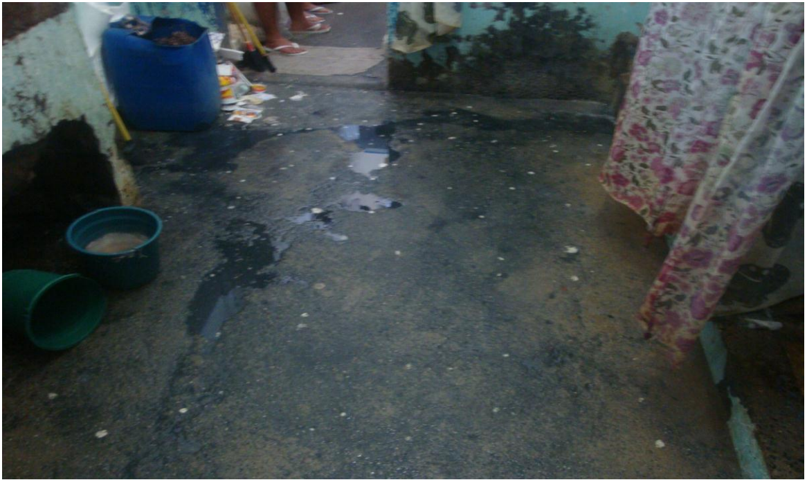
Imagem 27 – Banheiros ficam constantemente alagados por falta de manutenção hidráulica
