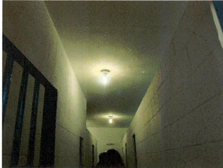
Instalação elétrica no corredor.
