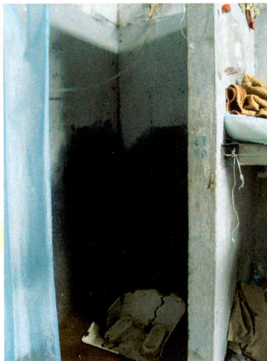
Banheiro de uma cela.
