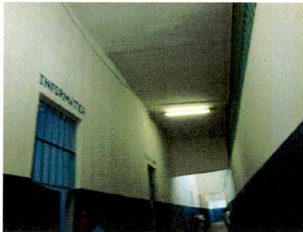
Sala de informática em construção.
