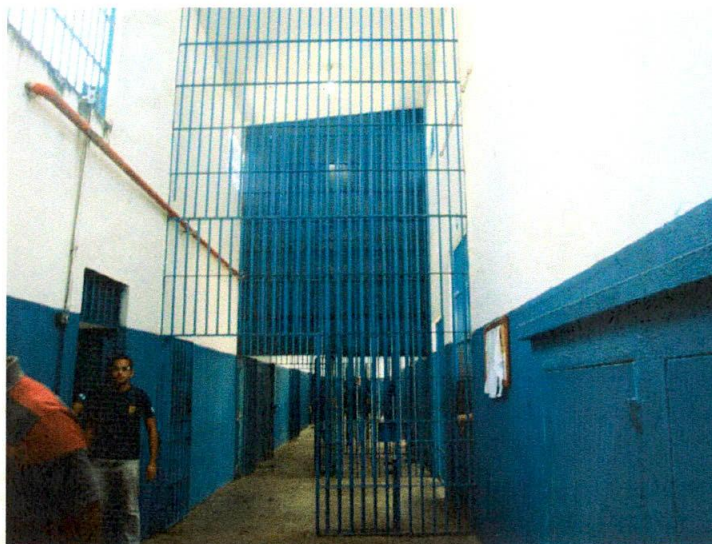
Corredor de um pavilhão.
