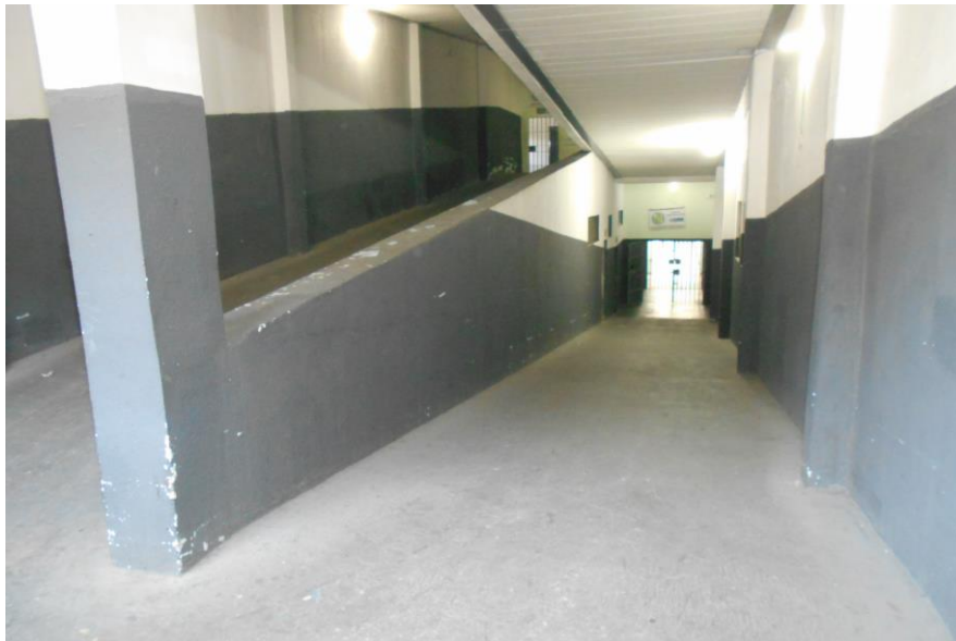
Rampas que dão acesso às galerias nos pisos superiores.
