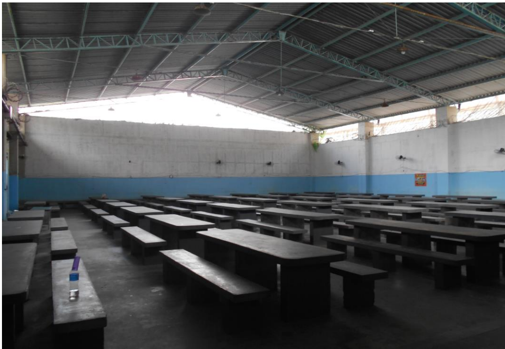
Visão interna do pátio de visitas.
