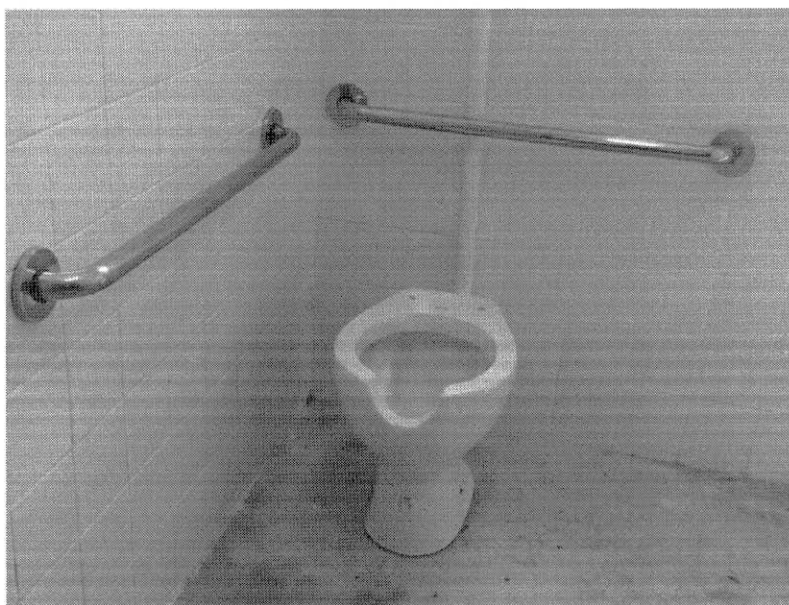
Foto 47. Barras de apoio do banheiro do Pátio de Visitas destinado às pessoas com mobilidade reduzida
