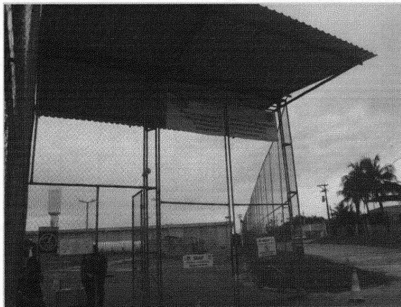
Foto 1. Entrada para o Complexo Prisional de São Gonçalo – portaria comum a ambas as unidades prisionais (ISAP Tiago Teles de Castro Domingues e Juíza Patrícia Acioli)
