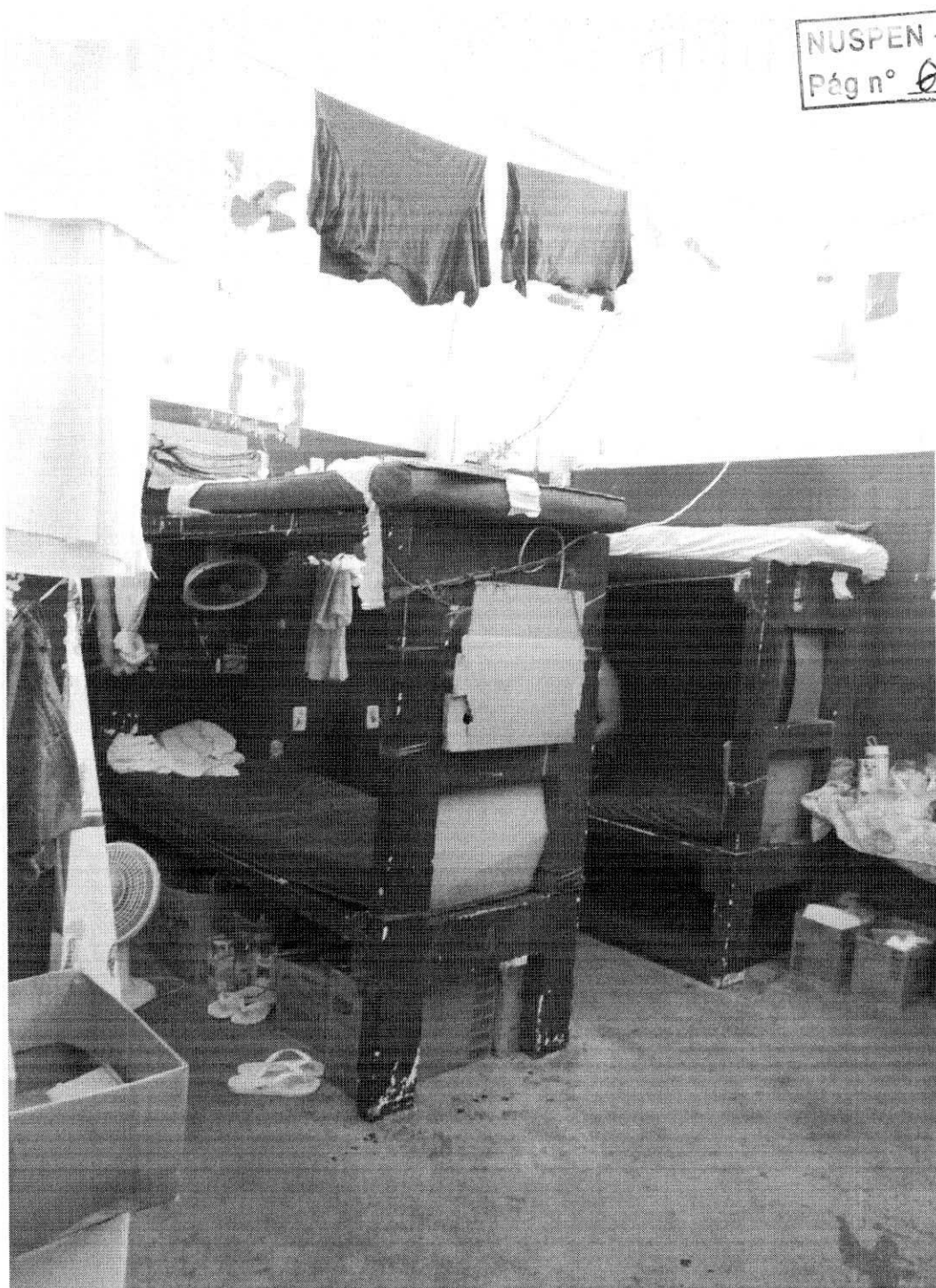
Foto 24. Fios passando entre as camas onde dormem os internos
