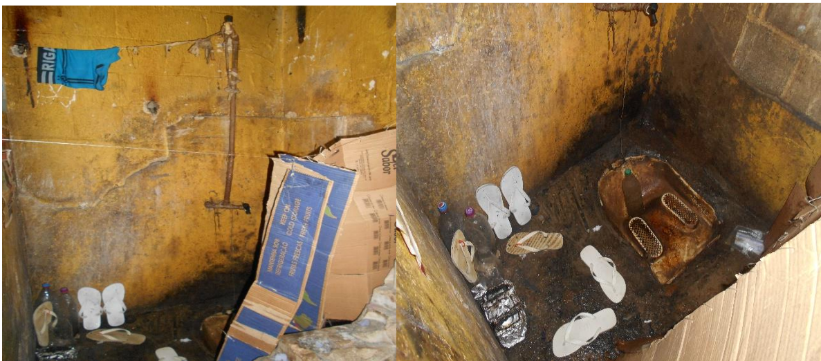
“Banheiro” da cela de acautelamento
