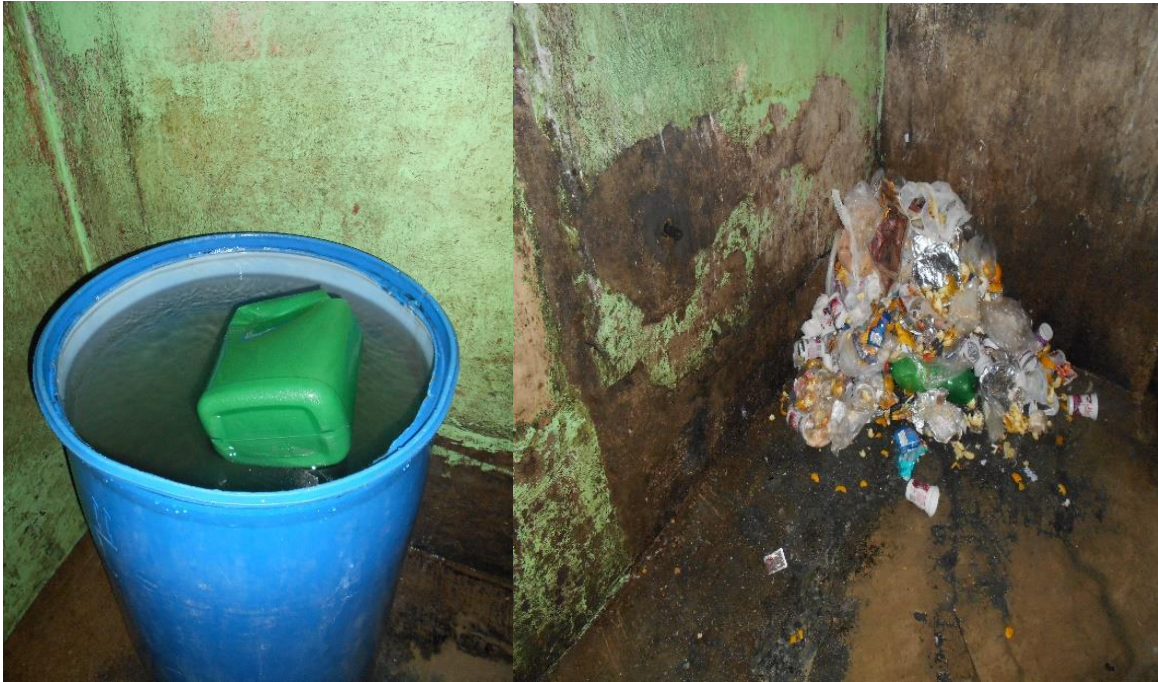
Tonel que armazena a água e lixo acumulado no banheiro de uma cela.
