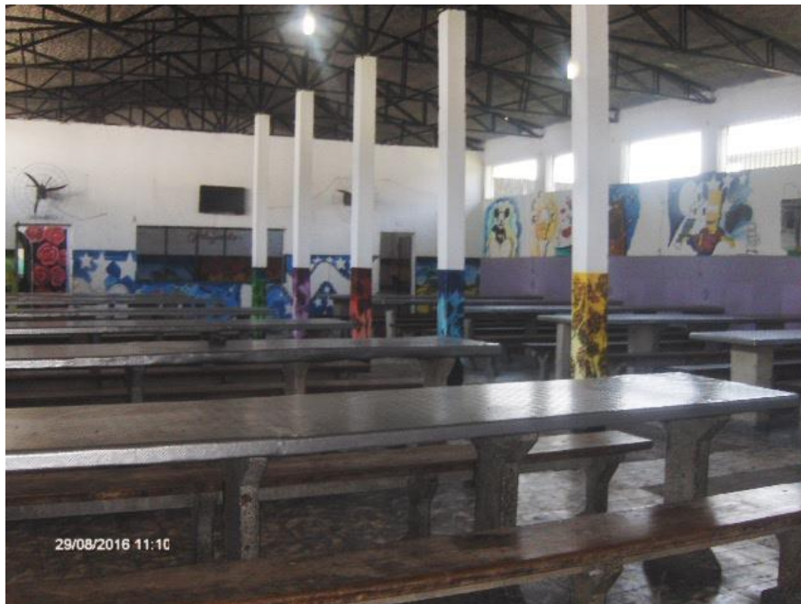
Refeitório que ligava as duas galerias da unidade.
