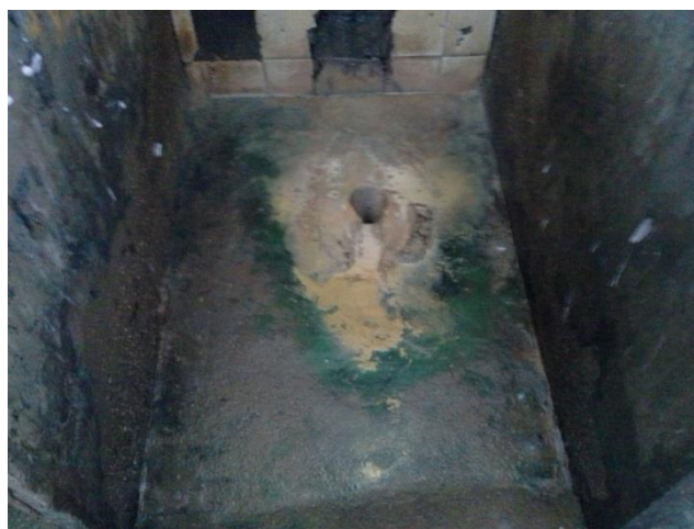
Foto 19. Bois entupidos, quebrados e que servem de caminho para a circulação de ratos e insetos.
