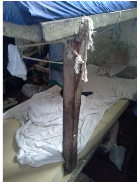
Fotos 21 e 22. Comarcas sustentadas por pedaços de madeira e barbantes - altíssimo risco de morte, acidente comum em diversas unidades prisionais inspecionadas por este núcleo.
