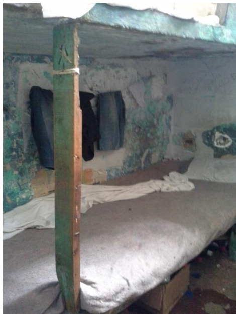
Fotos 21 e 22. Comarcas sustentadas por pedaços de madeira e barbantes - altíssimo risco de morte, acidente comum em diversas unidades prisionais inspecionadas por este núcleo.
