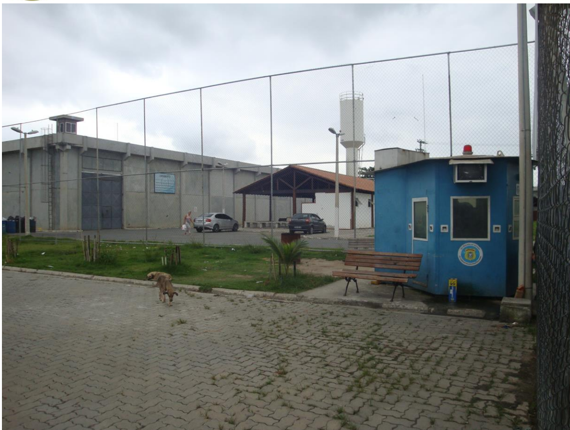
Foto 2. Vista do presídio a partir do estacionamento do mesmo.
