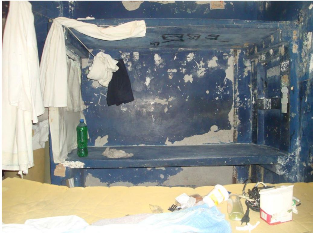
Foto 5. Comarcas sem colchões e uma espuma servindo de um. Paredes visivelmente degradadas. Roupas e toalhas expostas, sem local para sua respectiva reserva.
