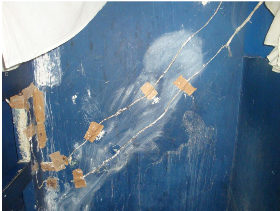
Foto 9. Mais mergulhões/pererecas: conectados e presos à parede por fita adesiva.
