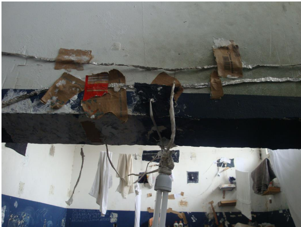
Foto 7. Mergulhões/Pererecas conectados e presos à parede por pedaços de papelão, gerando energia para uma lâmpada.
