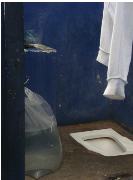
Foto 11. Reservatório feito com saco de plástico.
