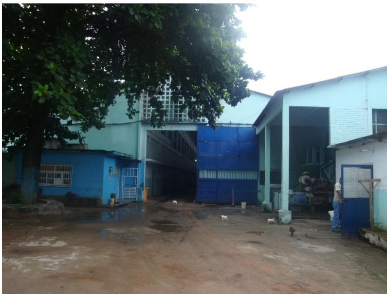
Foto 21. Estrutura predial que abriga as diferentes atividades desenvolvidas pelos presos a partir da contratação por empresas - elas são divididas por "box".
