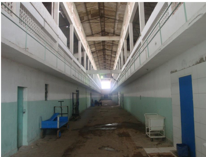
Foto 22. Aspecto interior da imagem 21.
