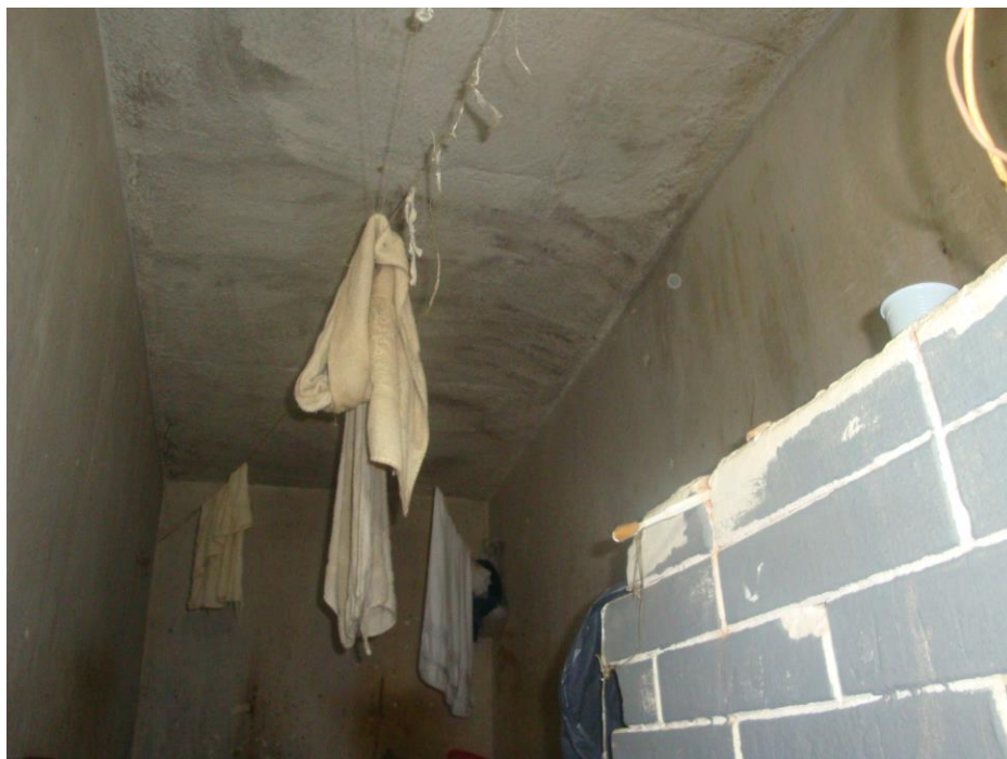
Foto 42. Interior da cela de Isolamento.
