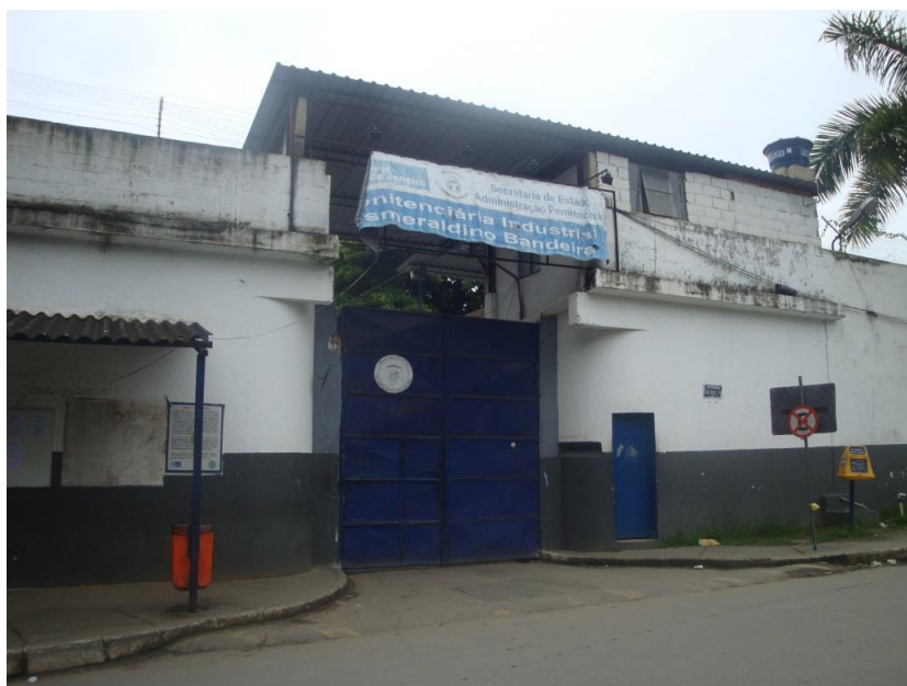
Foto 1. Entrada da estrutura predial da unidade
