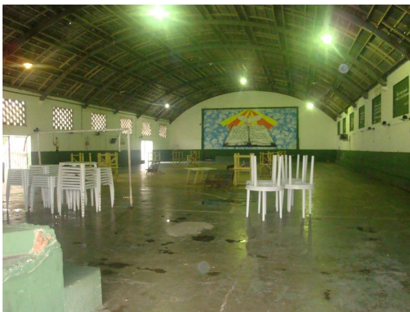
Foto 27. Interior do Galpão de Visitas.
