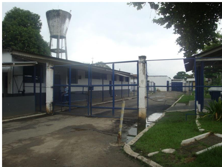
Foto 4. Primeiro portão após portaria.
