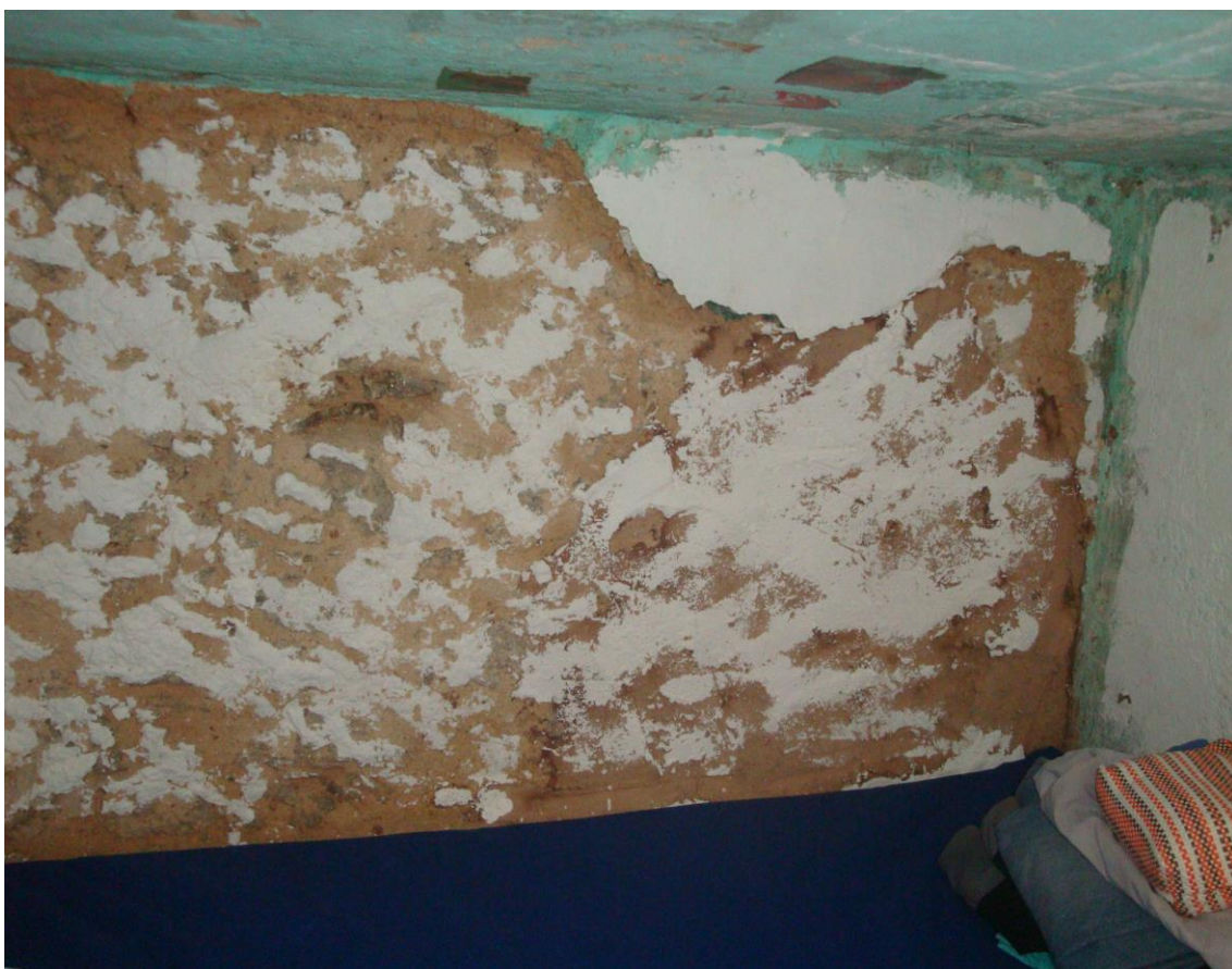
Parece de cela, com pintura e reboco absolutamente comprometidos por infiltrações.
