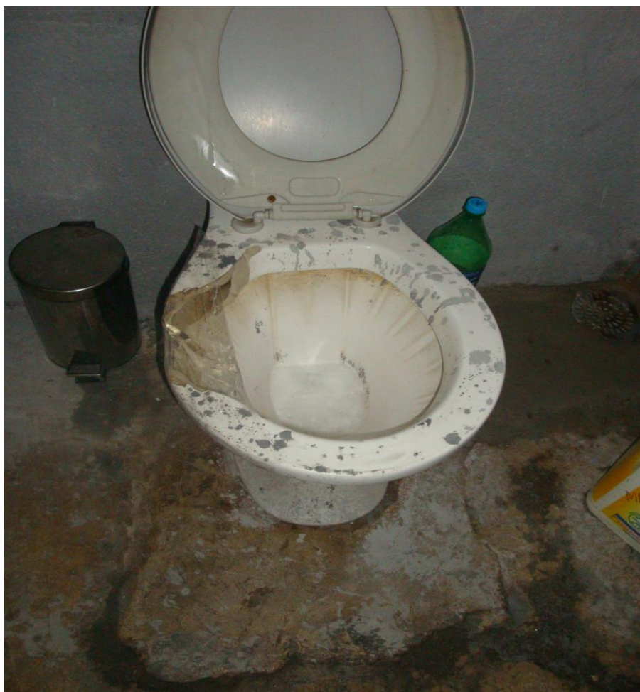
Vaso sanitário com fita adesiva em razão de rachadura
