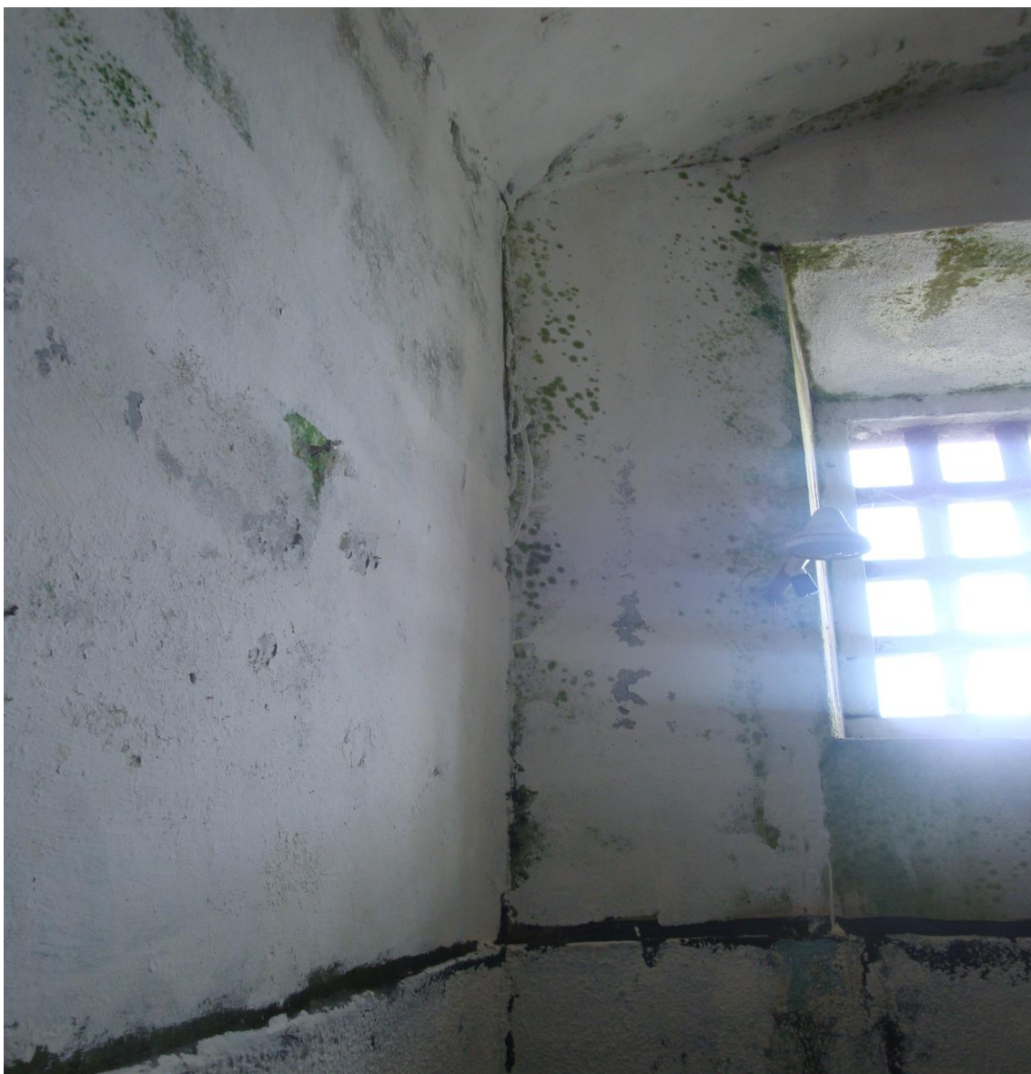
Mais exemplos de mofo nas paredes das celas.
