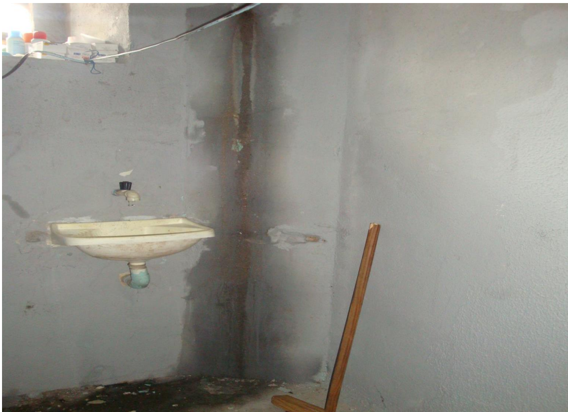
Claros sinais de infiltrações em uma das celas.
