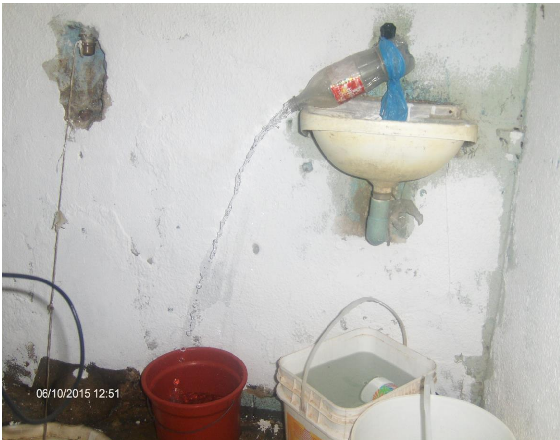
O improviso nas pias, chuveiros e sanitários é notado em praticamente todas as celas do pavilhão das praças.
