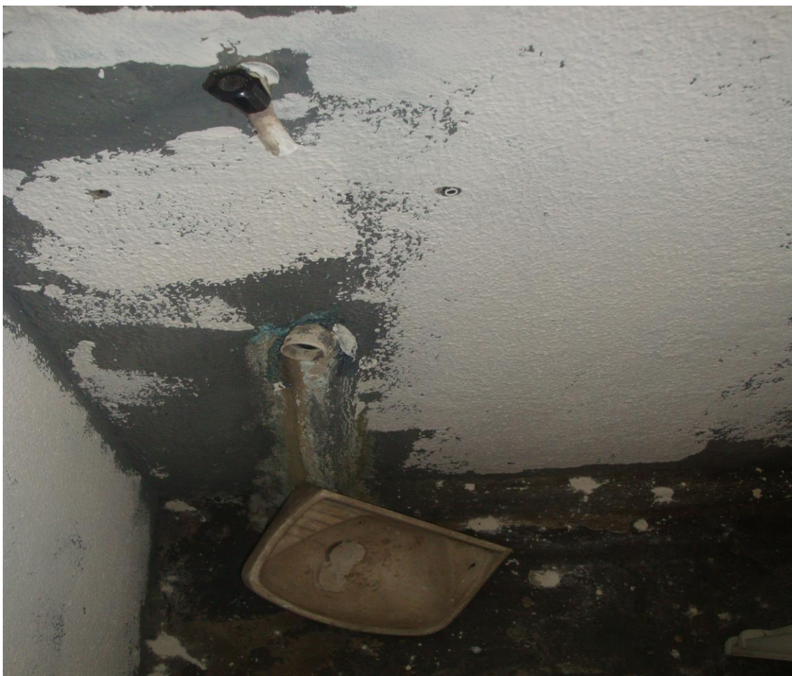
Pia caída no chão e mais sinais das infiltrações presente em todas as unidades.
