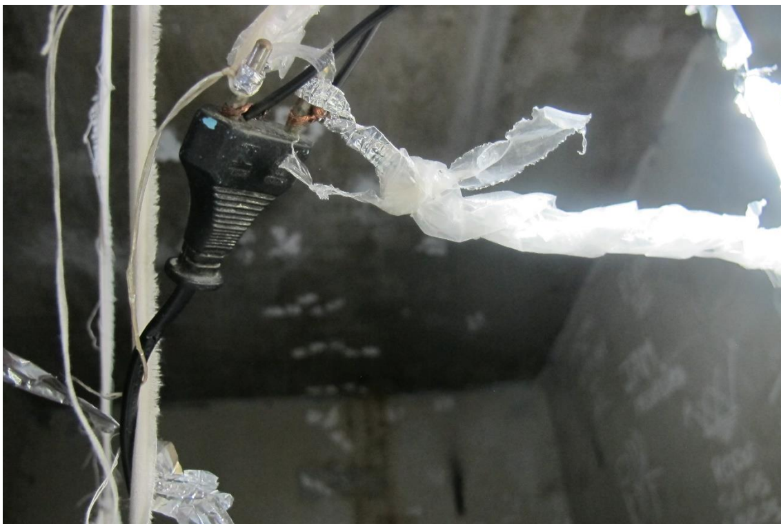
Foto 7. No detalhe, os materiais utilizados: plástico, papel, barbante, pequenos fios de cobre, uma tomada e alumínio; grande risco de curto circuito, incêndio e nenhum indício de qualquer planejamento para resgate e evacuação caso haja algum incêndio.
