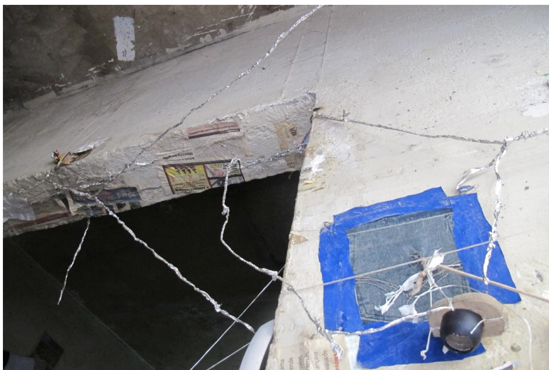
Foto 17. Mais um exemplo das "gambiarras" em busca de energia elétrica - pelas estruturas debilitadas das celas, um sem número de fios improvisados com pano, alumínio, papelão e plástico geram energia para diversas demandas de sobrevivência.
