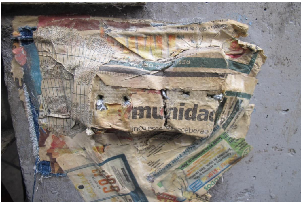
Foto 16. Instalação improvisada de tomada, utilizando alumínio, jornal, papelão e pedaços de telha.
