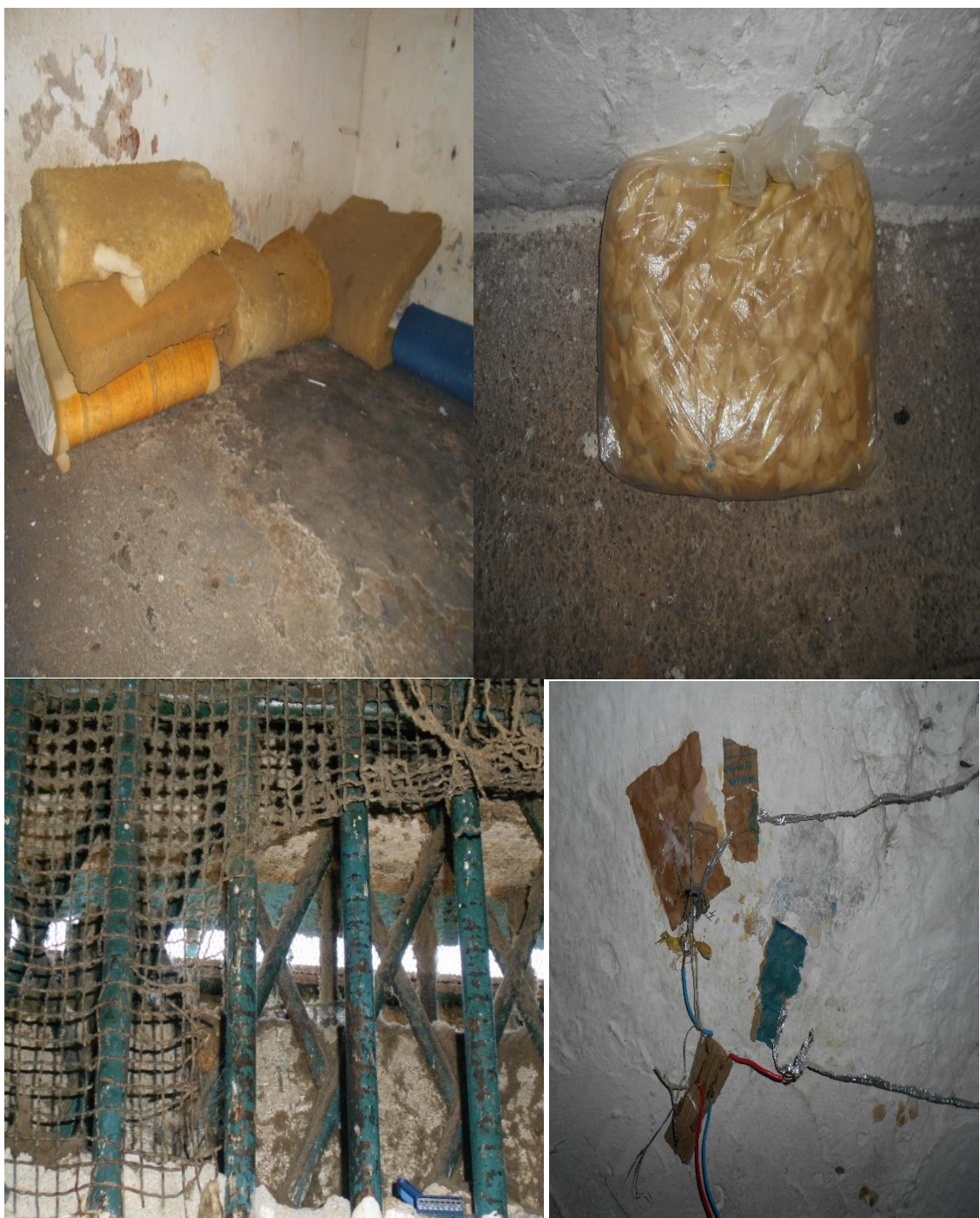
Figura 8: Acima, pedaços de espuma utilizados pelos presos e abaixo as precárias condições de aeração (janelas com diversos feixes de grades) e um exemplo das diversas "gambiarrias".
