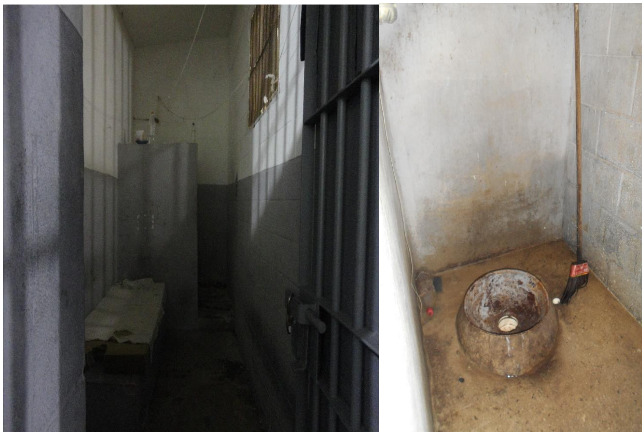
Uma das celas de isolamento, no detalhe, o banheiro.
