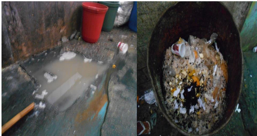
Banheiros com “bois” entupidos e lixo acumulado de restos de alimentos
