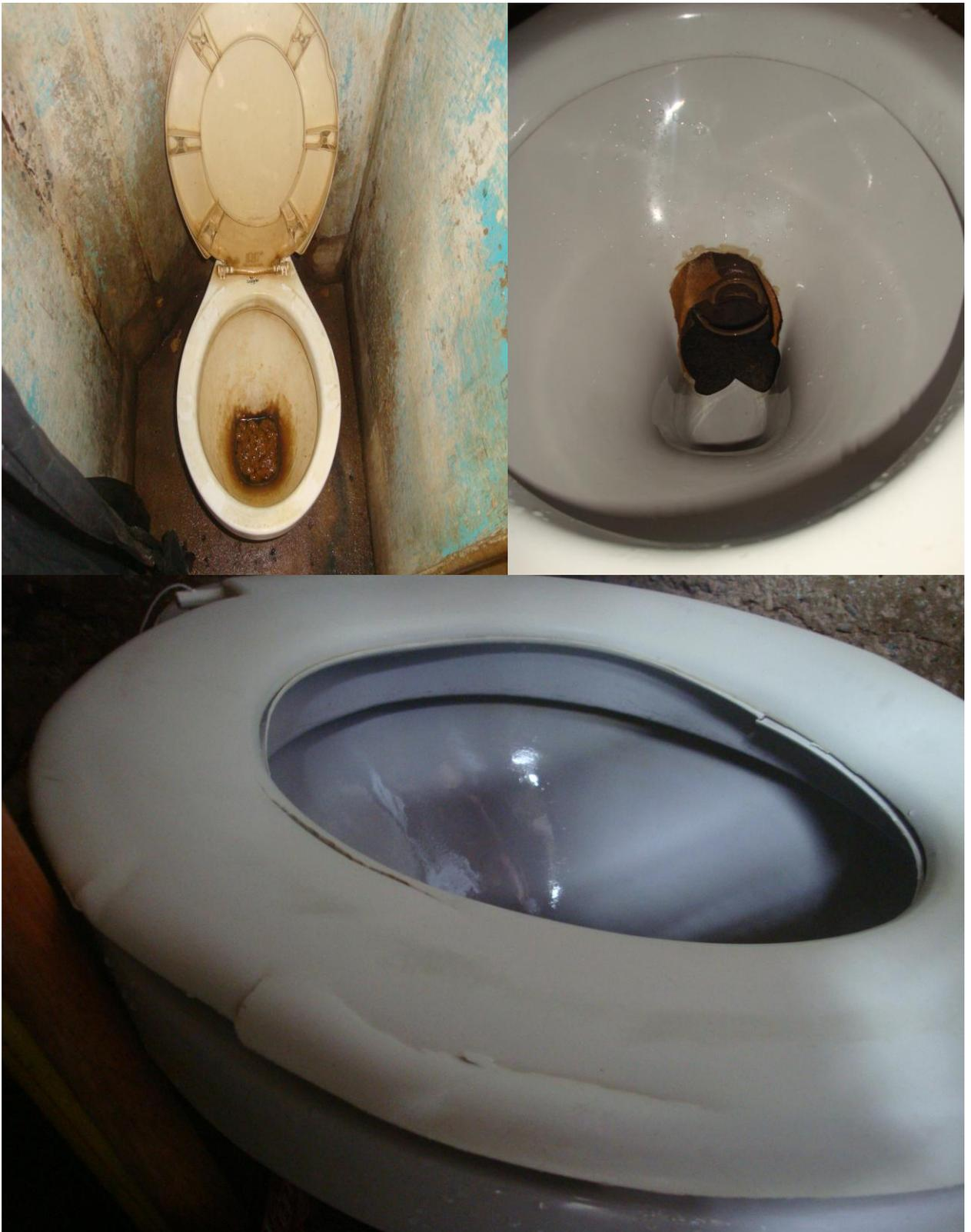
As imagens acima mostram exemplos de vasos sanitários instalados em celas que acautelam cadeirantes. Podemos notar uma completamente entupida, uma que sequer está instalada e sim quebrada e posicionada sobre o "boi" e na terceira o estado deplorável em que se encontra a tábua adquirida pelos próprios presos.
