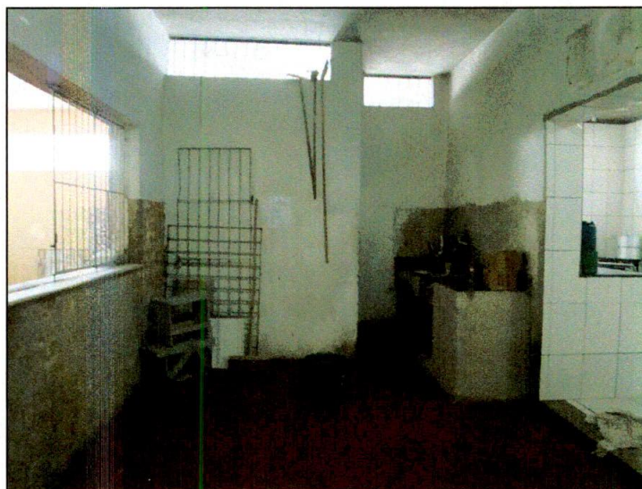
Cozinha do refeitório em reformas.
