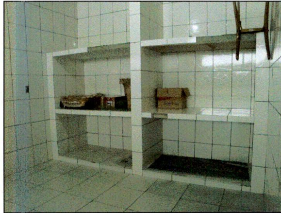
Depósito da cozinha em reforma.
