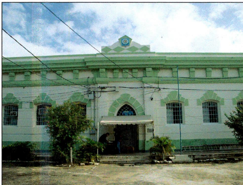
Fachada da Unidade.
