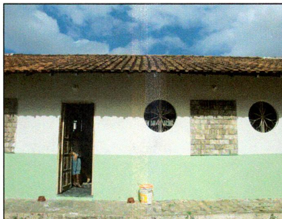
Local de alimentação dos funcionários.
