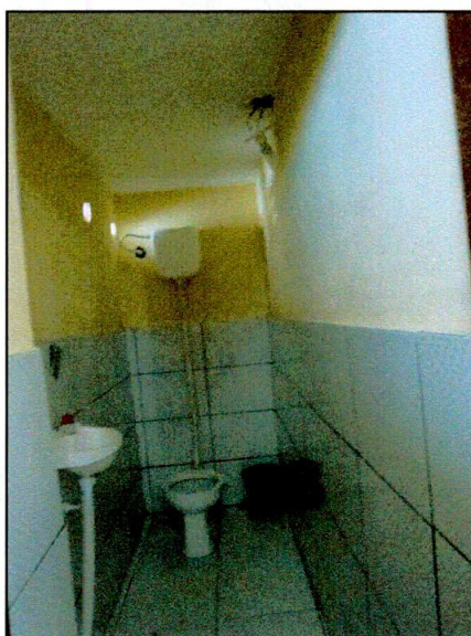
Interior do banheiro em funcionamento.
