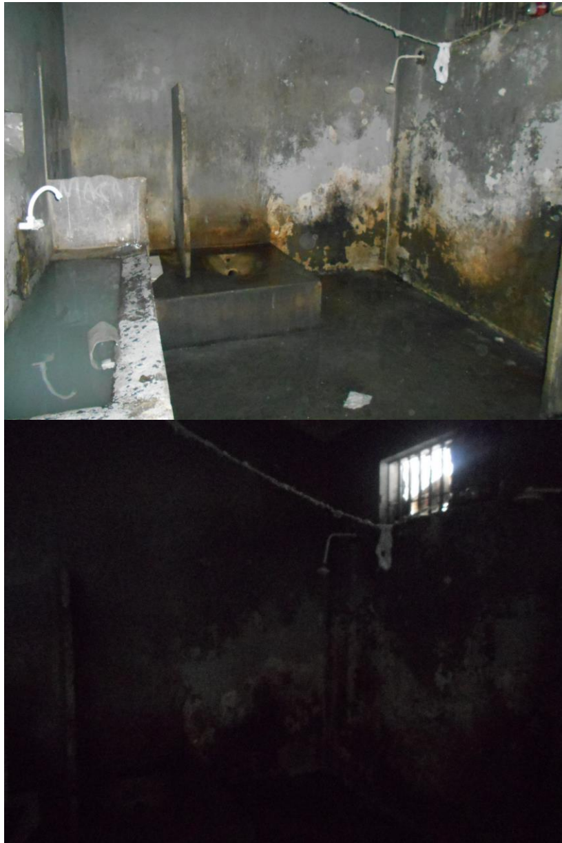
Fotos com e sem flash do banheiro de uma destas celas.
