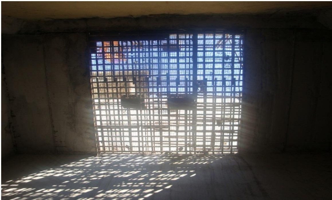
Imagem 22 - Parte do teto da cela por onde há entrada de luz natural e circulação de ar
