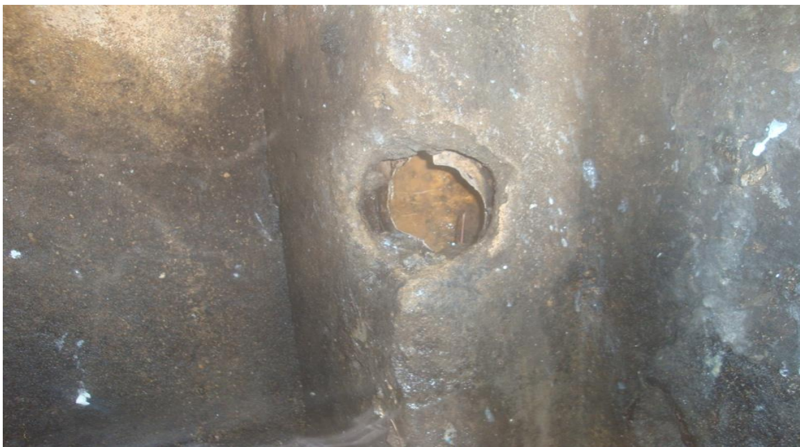
Imagem 11 - Buraco na parede de uma cela, por onde aparecem ratos e insetos.
