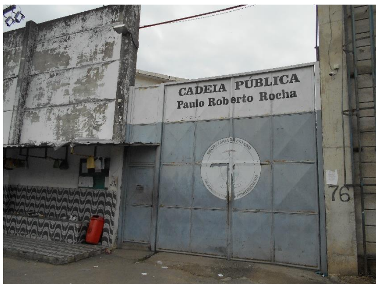
Fachada da SEAP-PR dentro do Complexo de Gericinó
